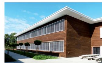
Was sicher auch daran liegt, dass das Schulhaus mit Unterstützung von Herz & Lang in Passivhausbauweise geplant und ausgeführt wurde. Im Winter wie auch im Sommer herrschen angenehme Temperaturen. Fünf zentrale Großlüftungsanlagen und 61 dezentrale Lüftungsgeräte sorgen stets für frische Luft – keine Spur von Schulhausmief.
