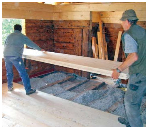
▲ Die alte Decke der Stube im Obergeschoss blieb als ursprüngliche Bohllendecke erhalten (links), mit Zellulose gedämmt (Mitte) und mit Dreischichtplatten ertüchtigt (rechts)
